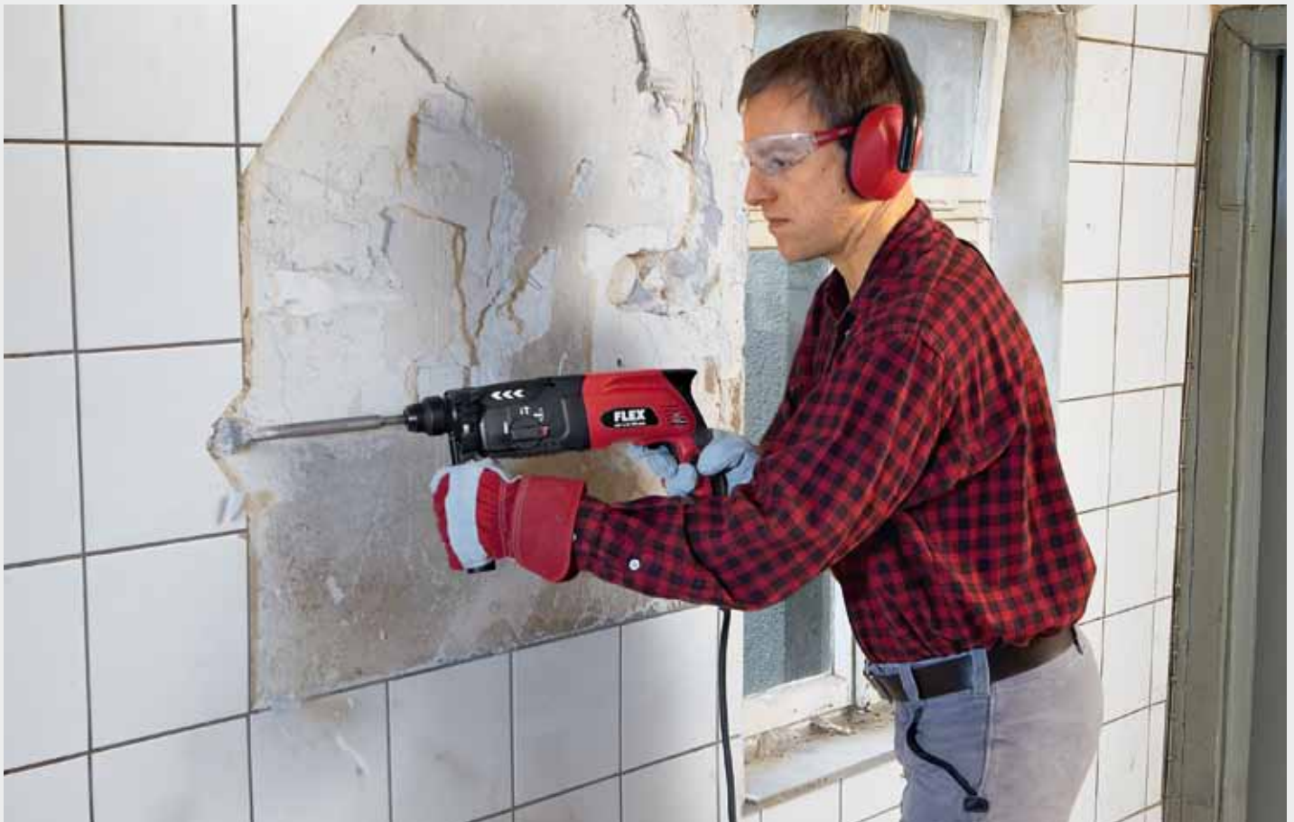
Klein aber oho. Selbst Wandfliesen sind für den CHE 2-26 SDS-plus dank seiner Meißelfunktion kein Problem. Der Meißel ist stufenlos positionierbar.
